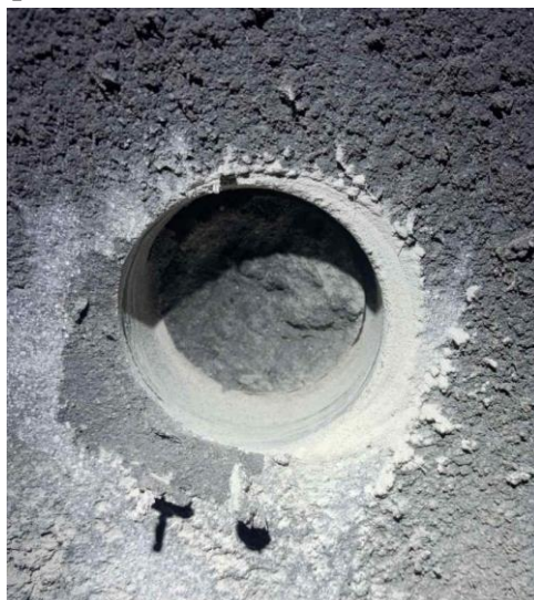
Рис.2. Шурф після відривання від масиву поверхні
