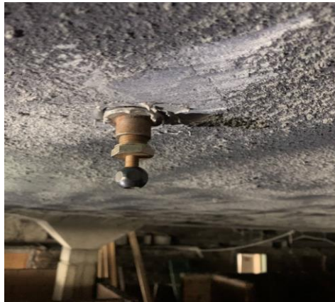
Рис.1. Підготовлений зразок для оцінки адгезійної міцності торкрет-бетону
