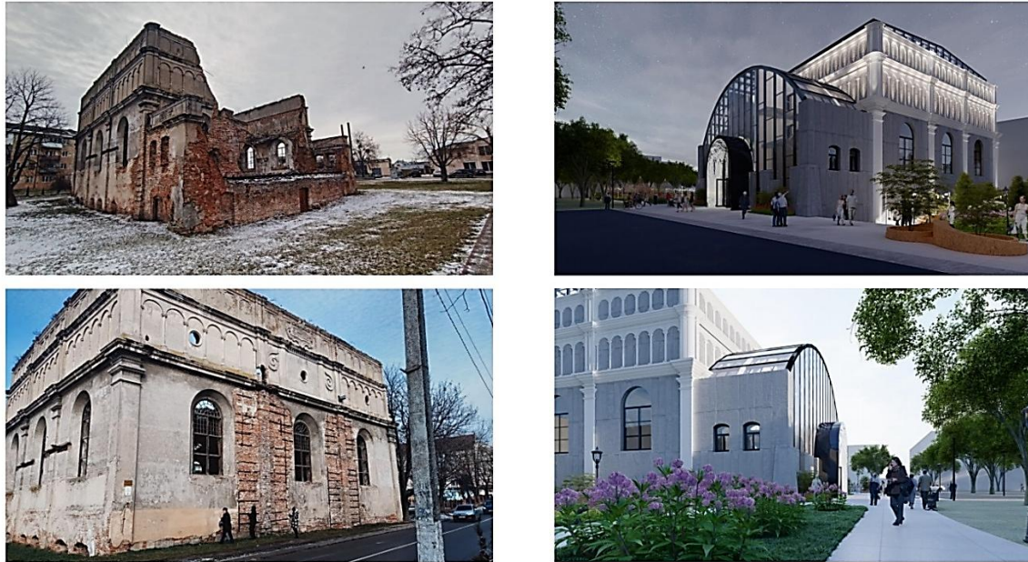
Рис. 1. Сучасний стан будівлі синагоги. Перспективні зображення будівлі синагоги в просторовому середовищі міста Броди. Проєкт ревіталізації.
