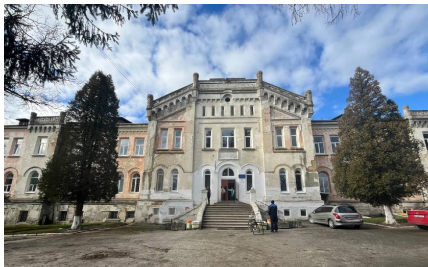
Рис.2. Фотофіксація існуючого стану будівлі основного корпусу доброчинного інституту С.Скарбека.
