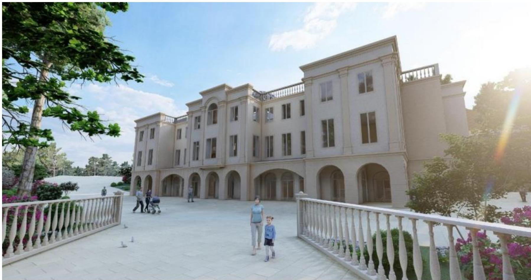
Рис.11. Загальний вигляд будівлі різниці-трапезної з площі Марійського духовного центру.
