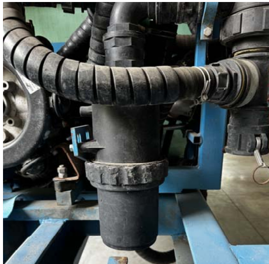
Рисунок 1.11.3. Основний фільтруючий елемент перед насосом.
